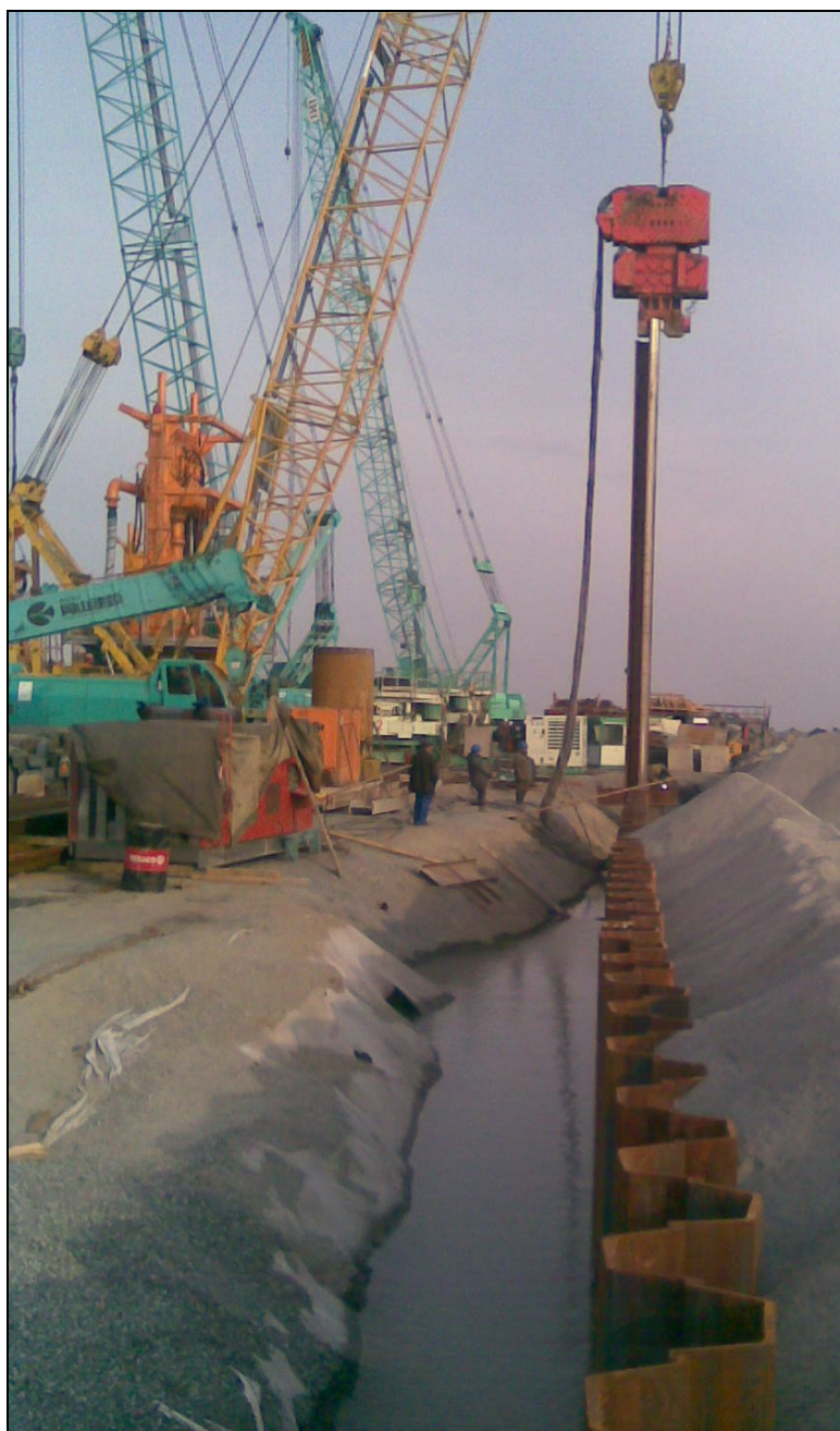
Для работы со шпунтовыми сваями используется зажимной наголовник AGRIPLEX 240 т
