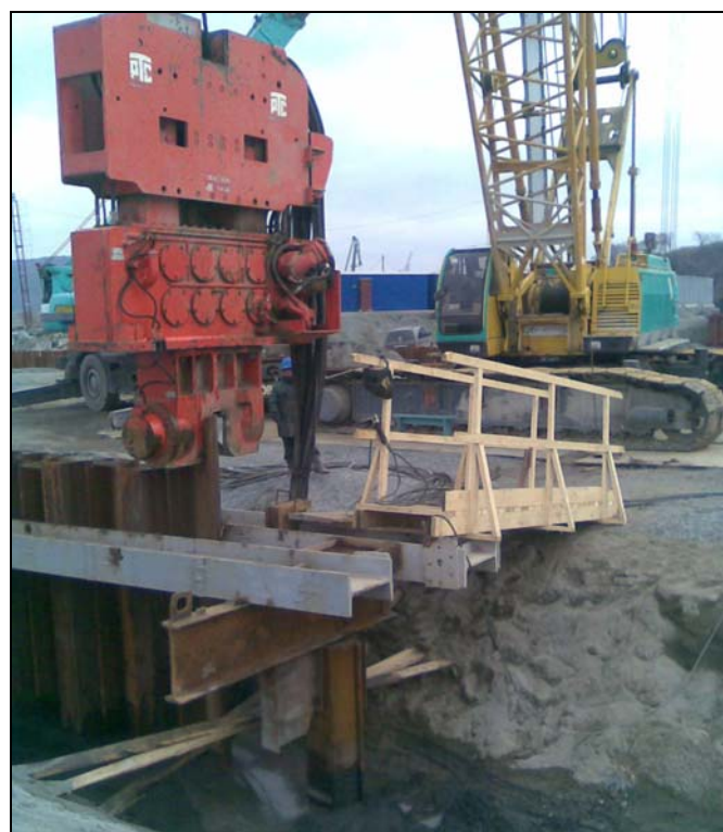
Для работы со шпунтовыми сваями используется зажимной наголовник AGRIPLEX 240 т
